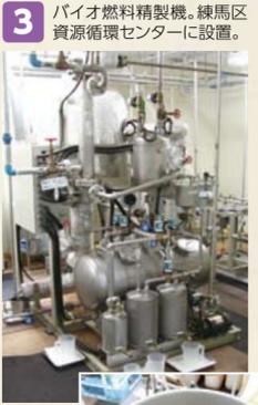
3 バイオ燃料精製機。練馬区資源循環センターに設置。
