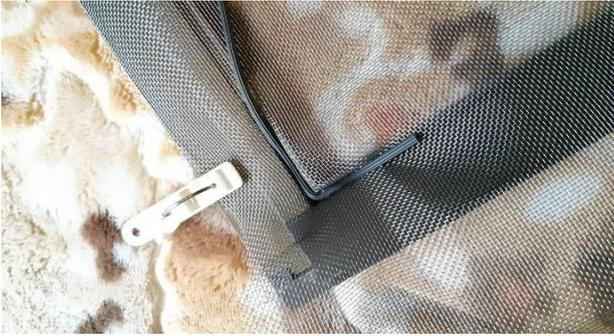
枠と網目が平行になるよう置きクリップや洗濯バサミなどで押えます。
