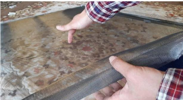
最初の2辺は、網戸と網が平行になるよう溝にゴムを押し込んでいきます。
