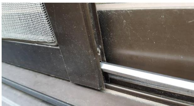
窓枠レールから戸車が外れないように調整されていたり、網戸の室内上部に外れ防止がついている場合がありますので、外れない場合は確認をしてください。戸車の高さは、写真のようにドライバーでネジを回すことにより高さを調整できます。網戸を上を持ち上げレールから外してください。
